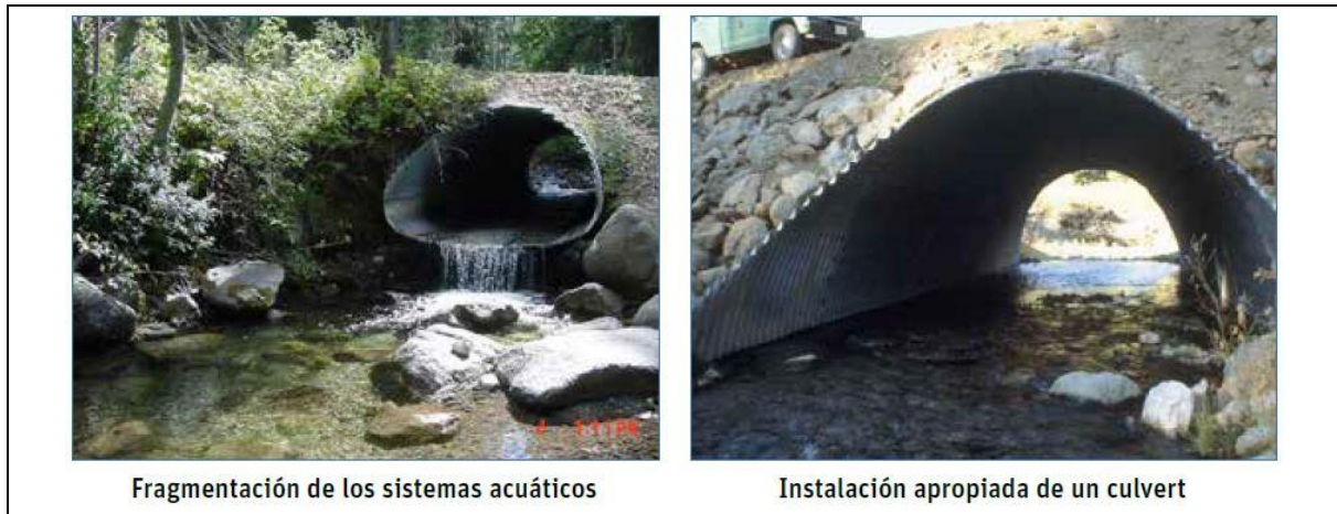
Figura 1. Alcantarillas y boxes, en relación con el nivel de la lámina de agua en estiaje.
